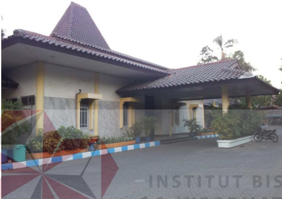
Gambar 2.1 Gedung Komputek Surabaya
