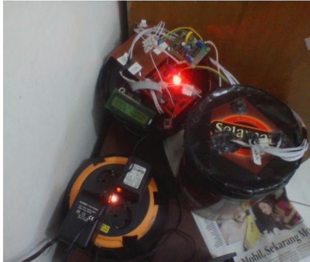
Gambar 3.4 Digester diletakkan pada salah satu sudut kamar
