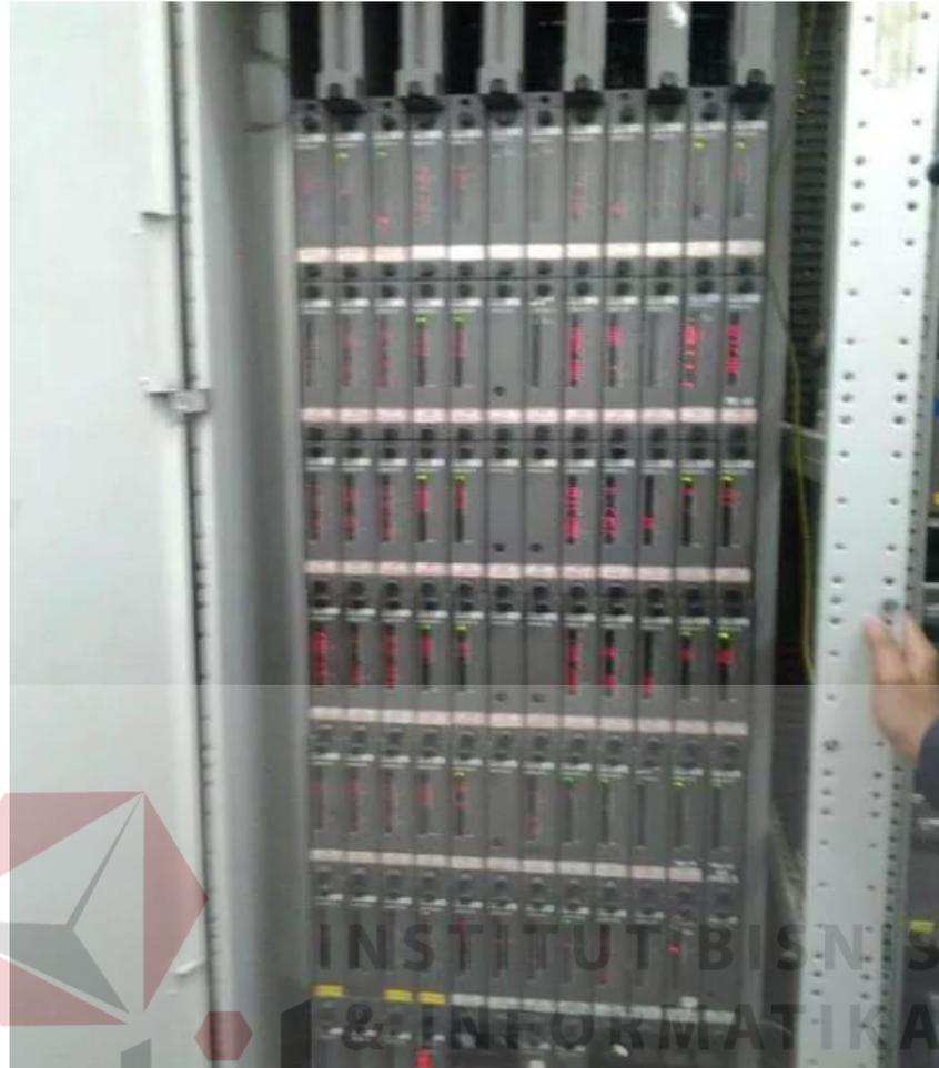
Gambar 3.16. Contoh modul-modul Komunikasi pada PLC Bailey
