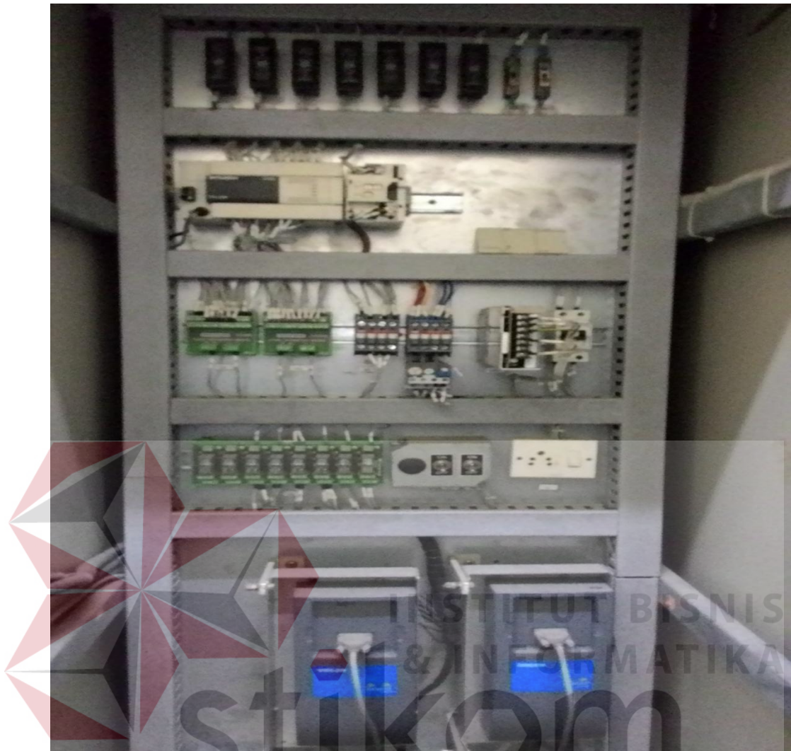
Gambar 4.4 PLC Mitsubishi yang digunakan untuk mengontrol mesin high grade fugal di pabrik gula
