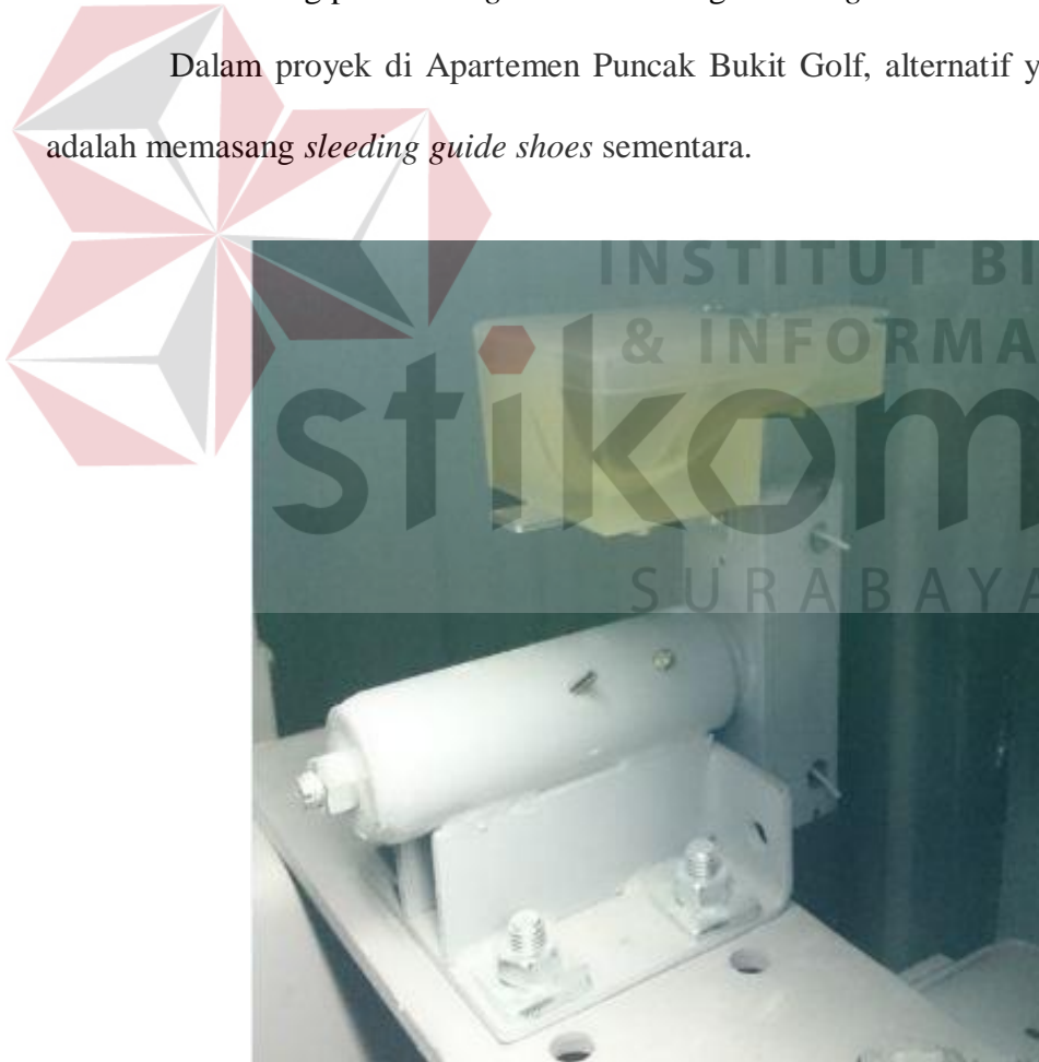
Gambar 4.2 Bentuk Asli Sleeding Guide Shoes
