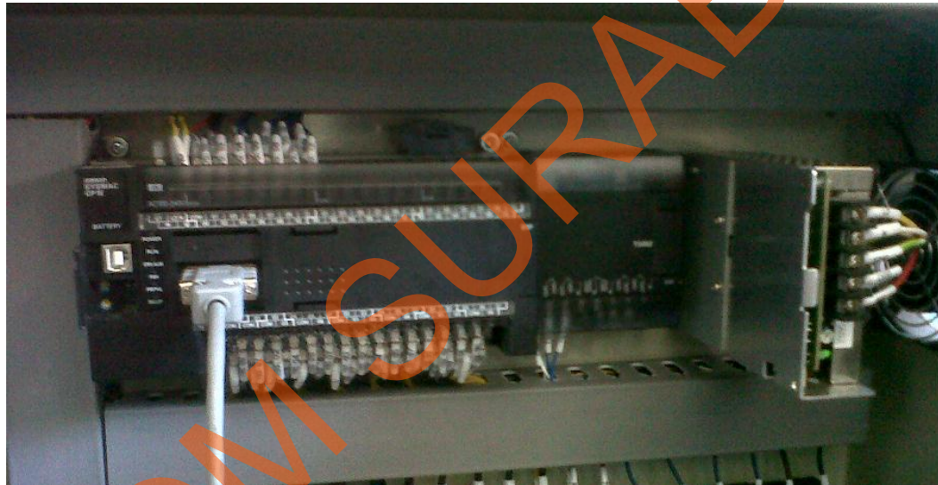
Gambar 4.11 PLC Omron yang digunakan untuk mengontrol mesin automatic mixing di pabrik pipa PVC.
