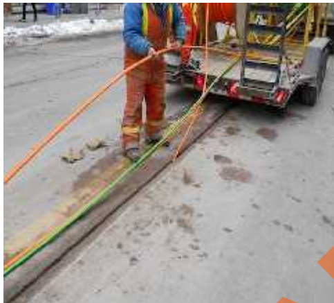
Gambar 4.13. Kabel pada galian. (www.e-knet.com)
