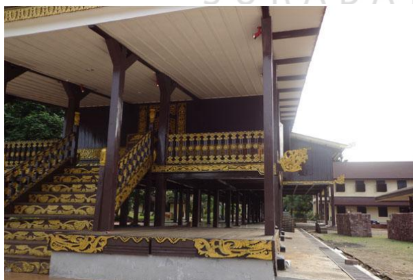
Gambar 2.14 Rumah Bubungan Tinggi Sumber: (Gambar Pribadi)
