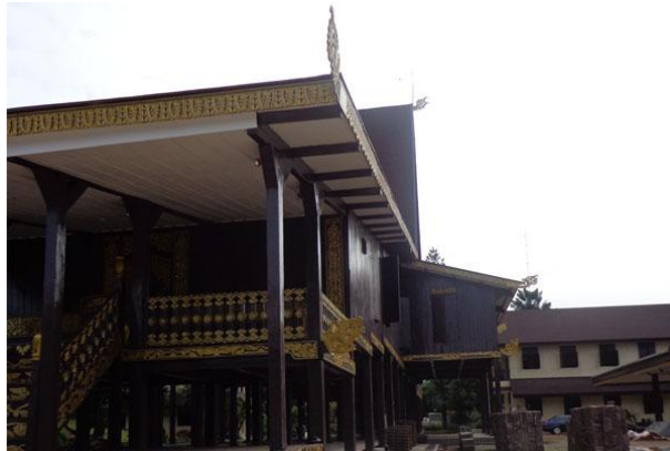
Gambar 2.15 Rumah Bubungan Tinggi Sumber: (Gambar Pribadi)
