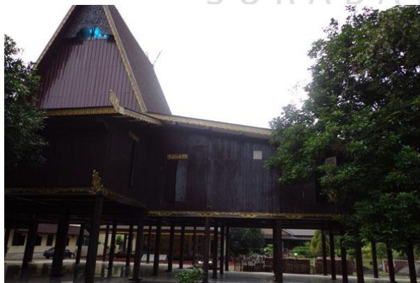
Gambar 2.20 Rumah Bubungan Tinggi Sumber: (Gambar Pribadi)
