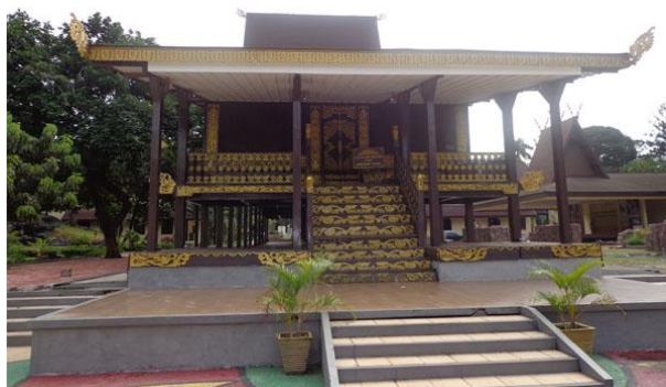
Gambar 2.17 Rumah Bubungan Tinggi Sumber: (Gambar Pribadi)
