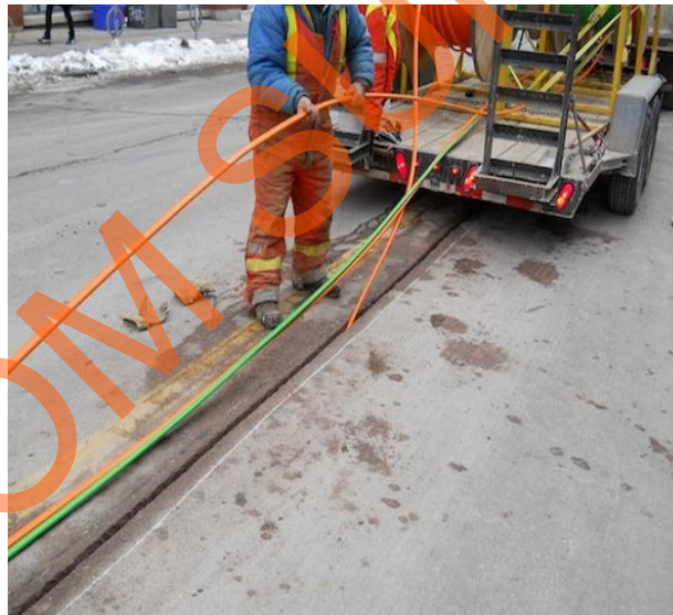
Gambar 4.14 Contoh bagaimana cocoknya ukuran hasil galian dari sebuah mesin (Diambil dari jarak jauh) ( www.e-knet.com )
