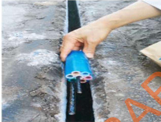
Gambar 4.13 Contoh bagaimana cocoknya ukuran hasil galian dari sebuah mesin (Diambil dari jarak dekat) ( www.e-knet.com )
