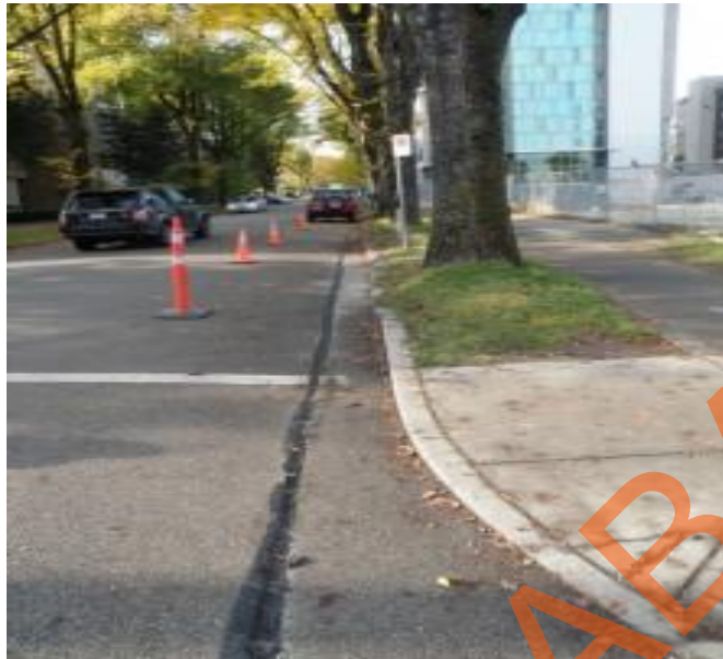
Gambar 4.11 Hasil penggalian menggunakan alat (Difoto dari jarak jauh). ( www.a2bfiber.com )
