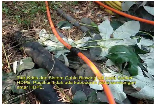
Gambar 4.17 Persiapan simulasi pemasangan serat fiber. (Diambil dari jarak dekat). ( www.diskominfo.jabarprov.go.id )
