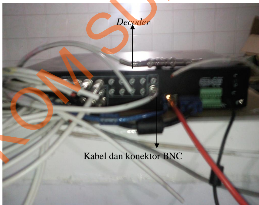
Gambar 4.23. Kabel dan konektor BNC dari kamera CCTV yang telah terhubung dengan decoder .
