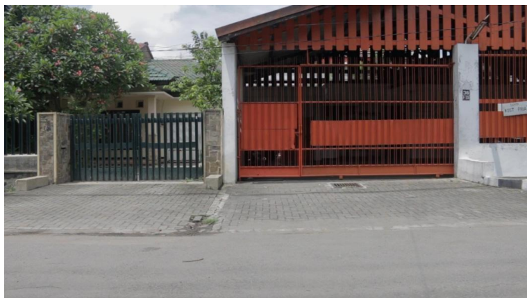
Gambar 4.5 Survei Lokasi 3 (Sumber: Olahan Penulis)
