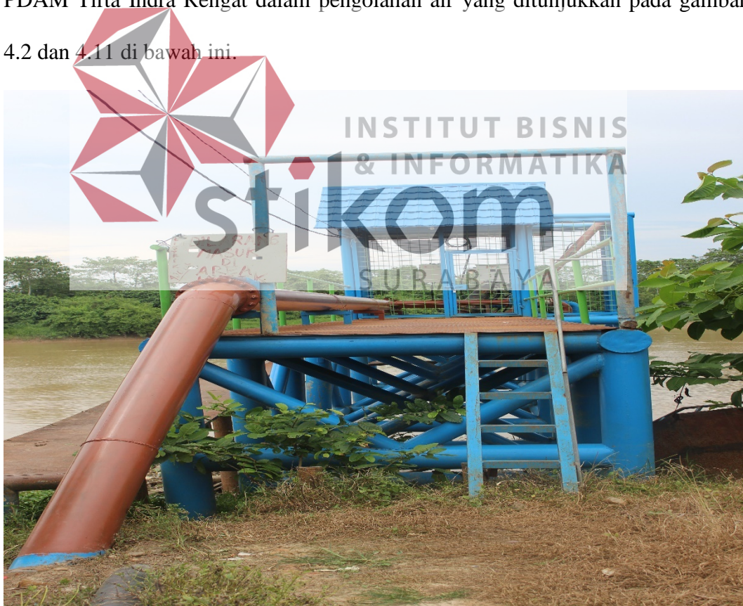
Gambar 4.2 Dokumentasi proses injeksi air sungai Indragiri
