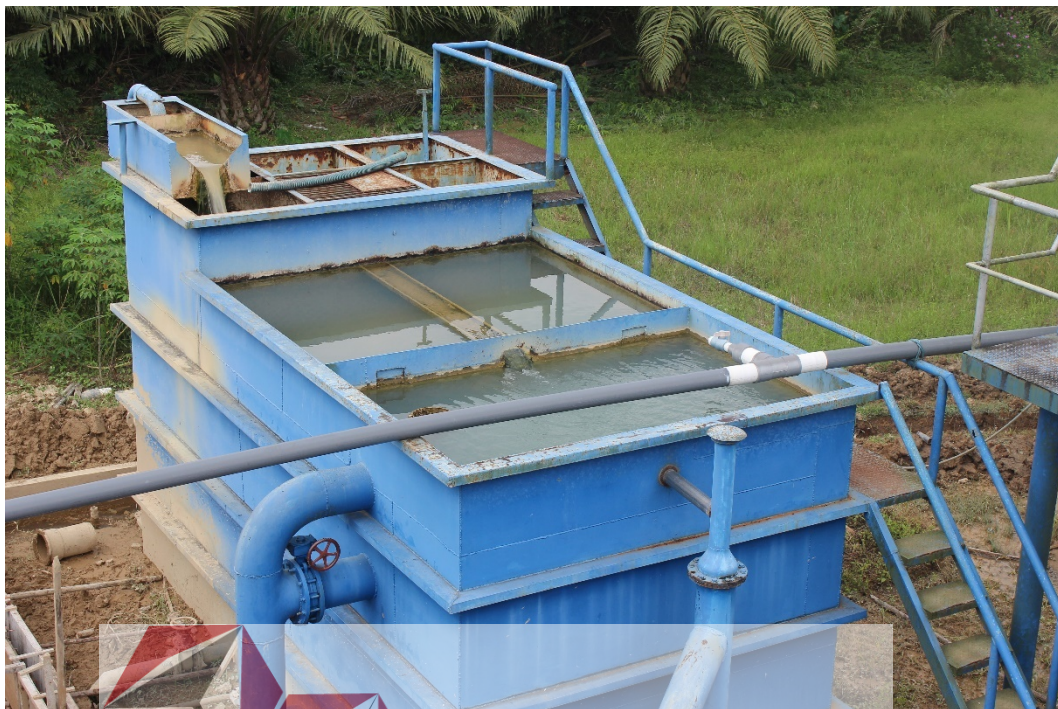
Gambar 4.5 Dokumentasi Filter Penyaring Air Bersih
