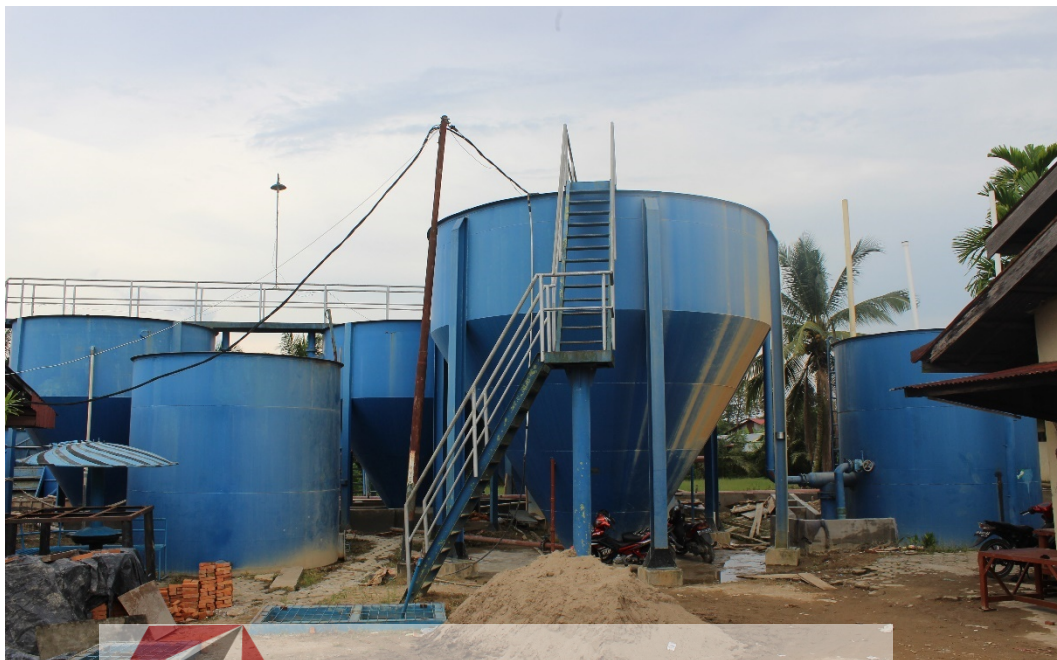
Gambar 4.3 Dokumentasi Clarifier/ Talang Air
