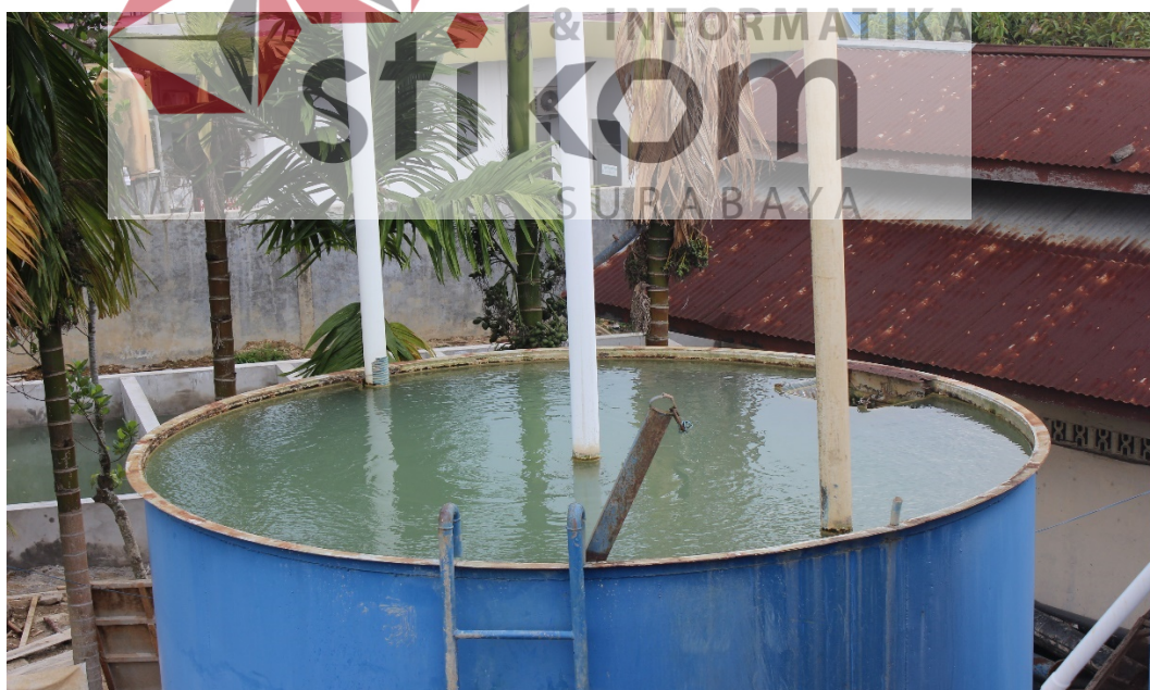
Gambar 4.4 Dokumentasi Tampak Atas Clarifier/Talang Air
