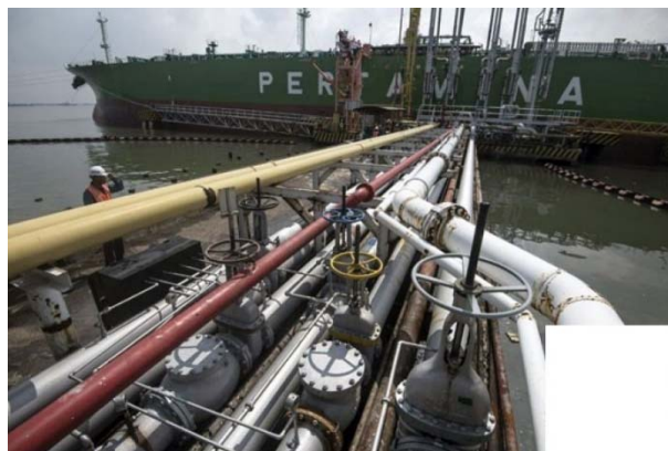
Gambar 2.5 Proses loading atau discharging produk
