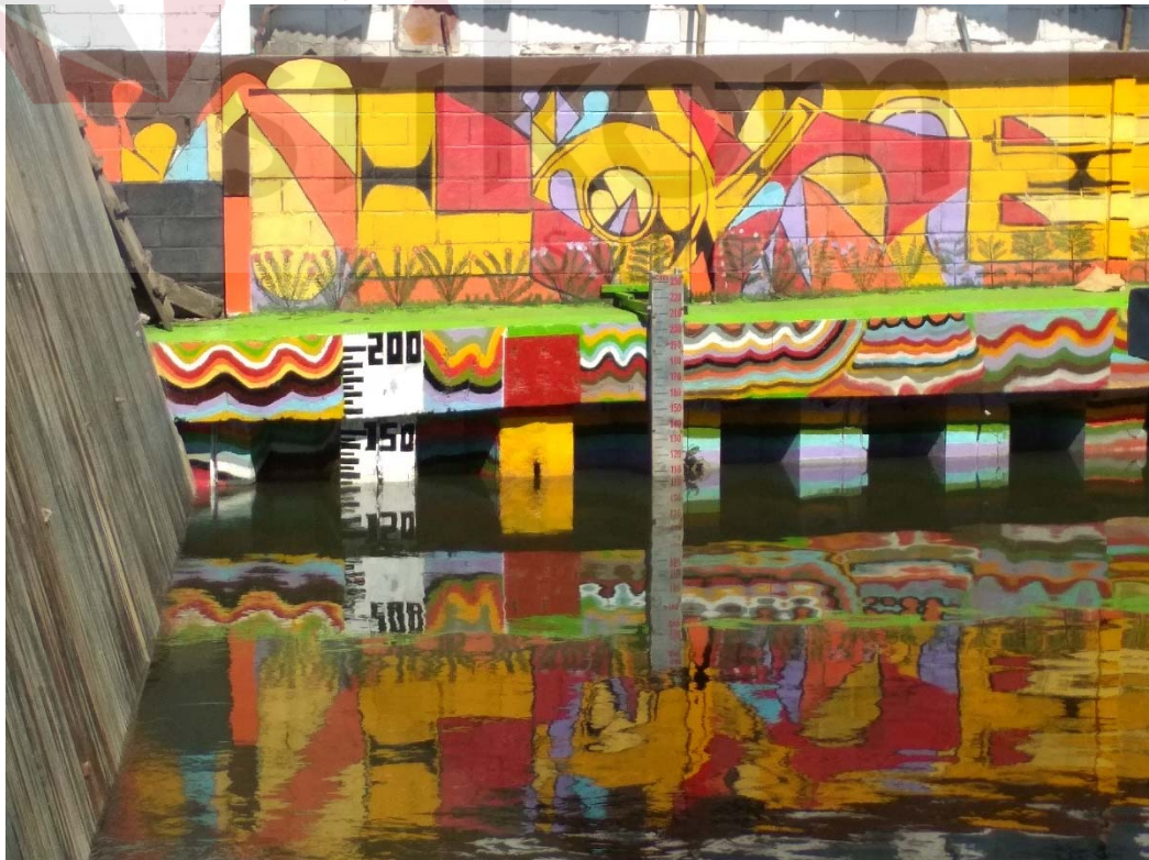
Gambar 1. 3 Alat Ukur pada Rumah Pompa
