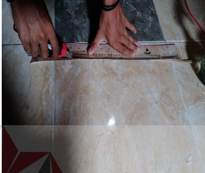
Gambar 4.34 Proses Menyamakan Tiap Sisi Material Eceng Gondok
