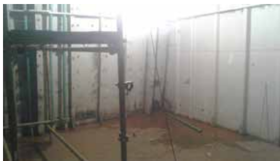
Gambar 4.8 Kondisi Sebelum Interior Kapal LPD
