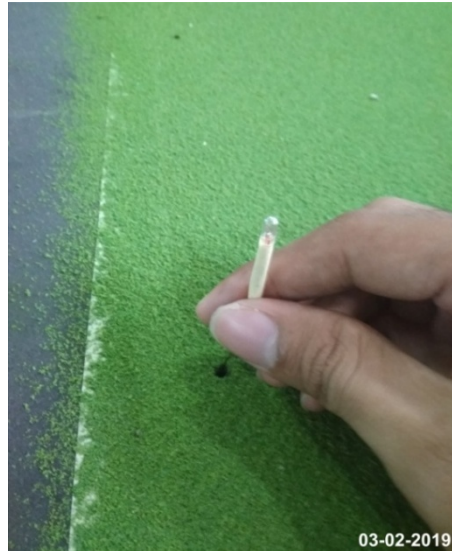
Gambar 4.55 Proses Pemasangan Lampu Tanam
