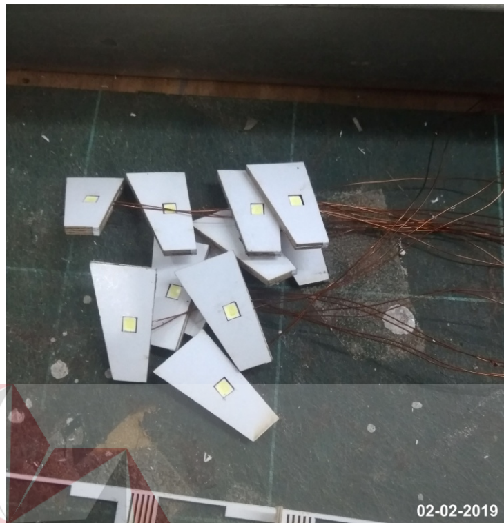
Gambar 4.53 Proses Pemasangan Lampu LED Untuk Balkon Apartment (Sumber : Dokumen pribadi)
