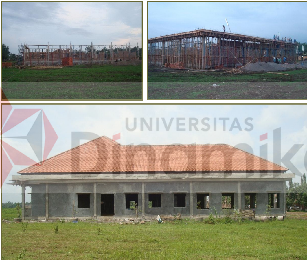
Gambar 2.3 Pembangunan Gedung Kantor Kementerian Agama Kab. Madiun
