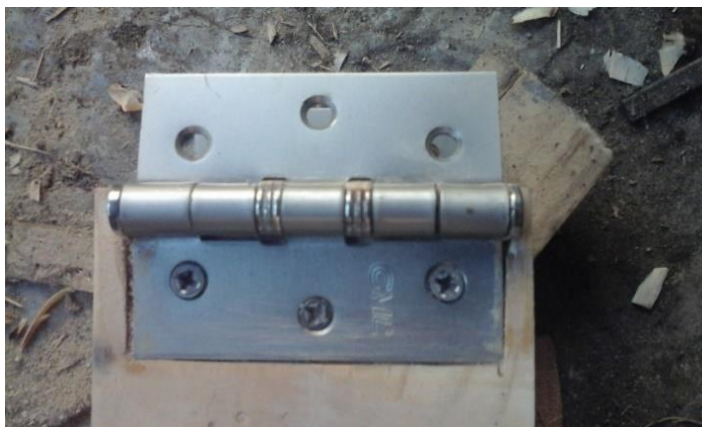
Gambar 4.14 Pemasangan Engsel (Sumber: Dokumen Pribadi)
