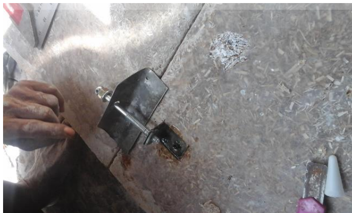
Gambar 4.16 Pemasangan Plat, dan Baut pada Papan
