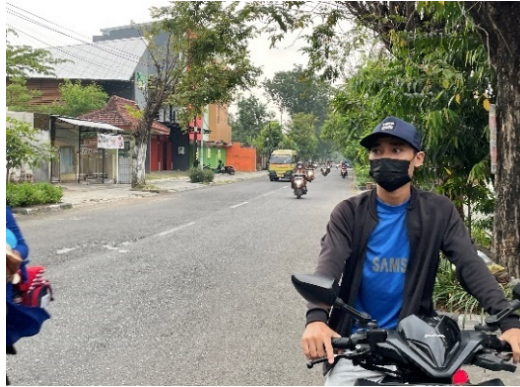
Gambar 4.6 Kondisi Jalan di Sore ke-2
