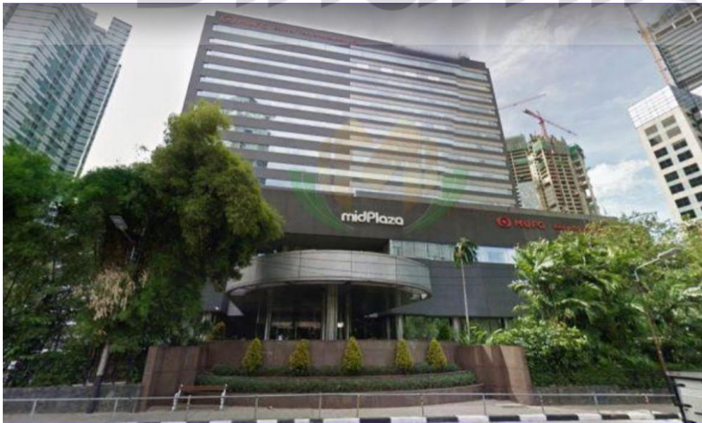
Gambar 1.1 PT. Mid Solusi Nusantara (Mekari) Gedung Midplaza 2, Lt. 4
