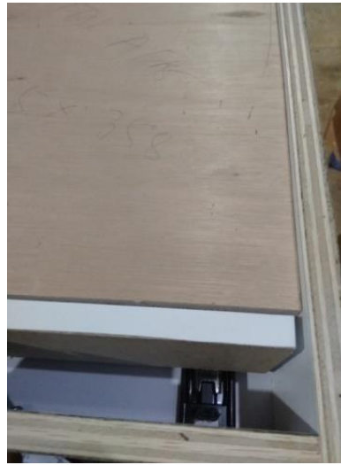
Gambar 4.8 Pemasangan ril/ Ball Bearing
