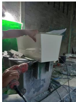
Gambar 4.14 Membuat Saluran Pembuangan Air
