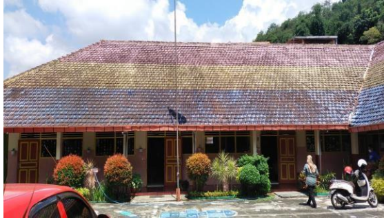
Gambar 4.8 Bangunan Sisi Kiri SDN Sumberejo 01 Batu
