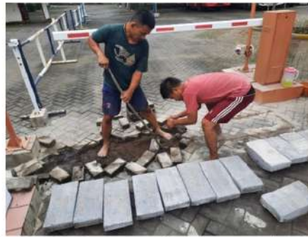
Gambar 7: Proses pembongkaran paving lama
