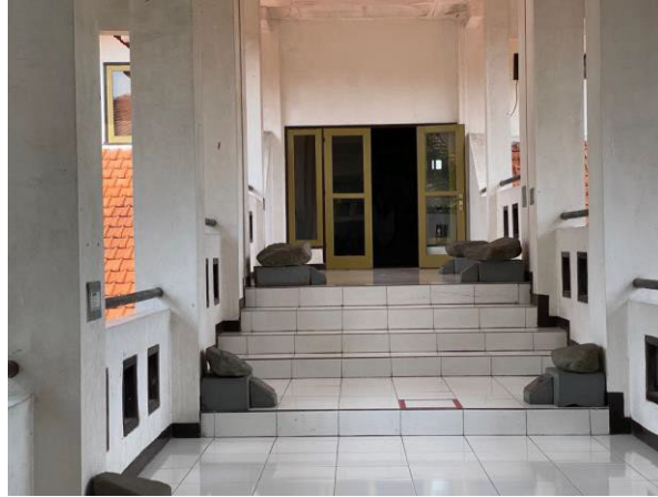
Gambar 4. 5 Lorong Lantai 2 Menuju Ruang Koleksi Gedung Von Faber
